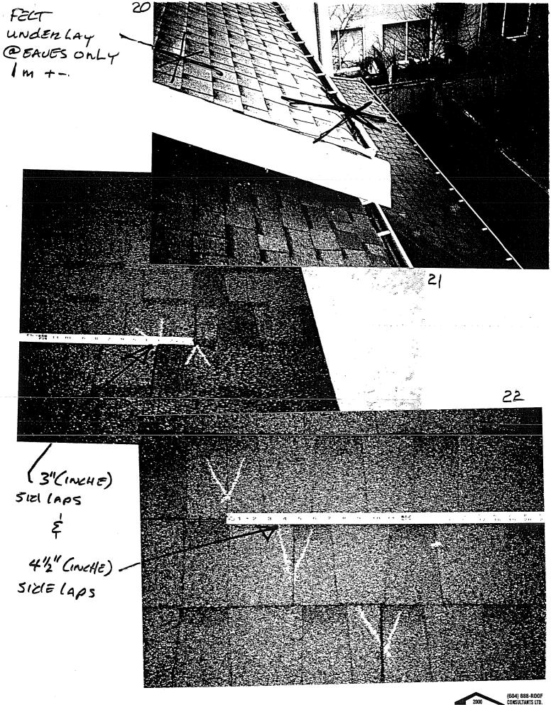
TYPICAL EXAMPLE OF NAIL HEAD PENTRATEING THROUGH THE SHINGLES
